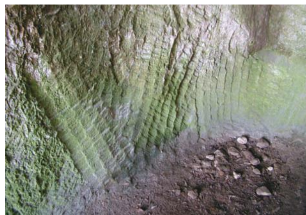
Fig. 12 - Segni di strumento utilizzato per asportare scaglie di calcarenite ricche di salnitro
