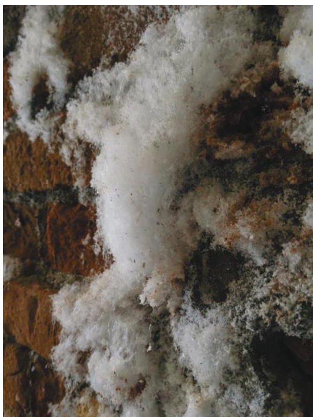
Fig. 1 - a) (a lato) Efflorescenza di salnitro su un muro; Fig. 1 - b) (sotto) Efflorescenza di salnitro su pavimento (foto di R. Paolicelli)
