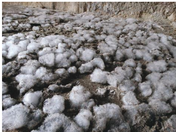
Fig. 1 - a) (a lato) Efflorescenza di salnitro su un muro; Fig. 1 - b) (sotto) Efflorescenza di salnitro su pavimento (foto di R. Paolicelli)
