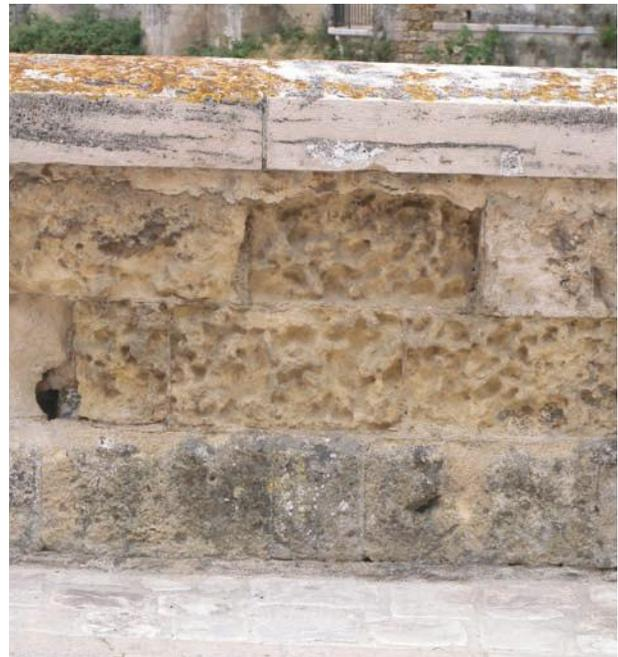
Fig.5- Una parete in via Sant'Angelo nel Sasso Caveoso. Il degrado dovuto all'evaporazione dell'acqua di umidità è molto profondo e diffuso. Minaccia il crollo della parete. (foto Di Lena)
