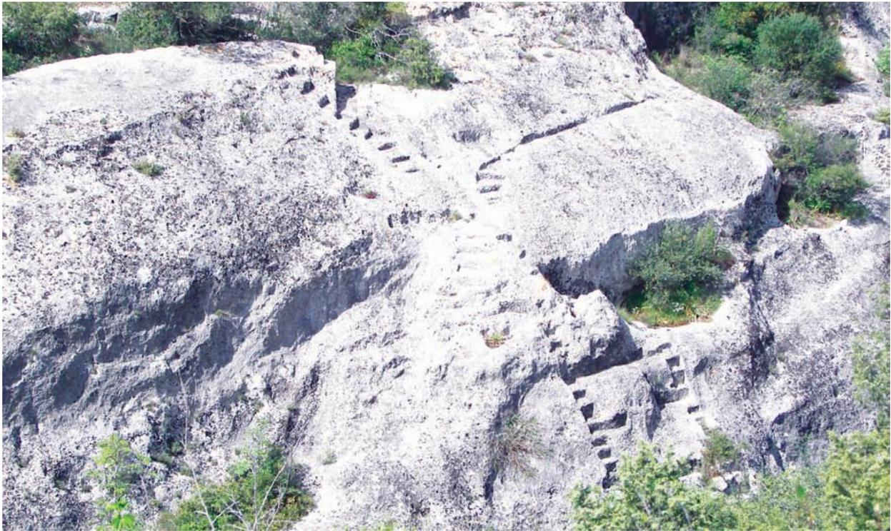
Fig. 8 - Tracce di ancoraggio e contigua cava impiegata per ricavare conci utili alla costruzione in situ del ponte (foto A. Fontana)
