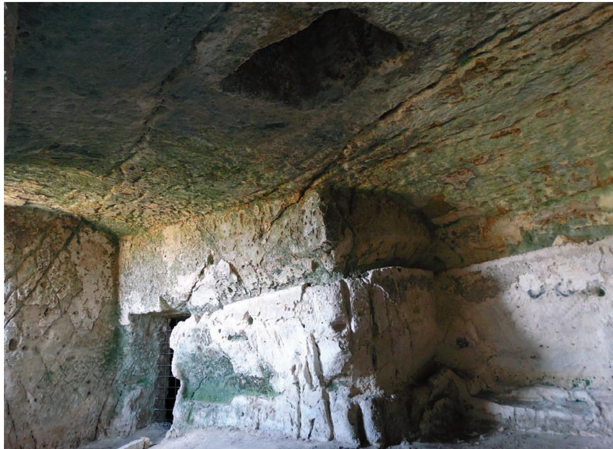
Fig. 7 – Interno dell’ipogeo relativo alla neviera Pizzuti. A sinistra il varco di accesso per la neviera, e alla destra di questa si nota la canaletta di adduzione ricavata nel perimetro della parete. In alto è presente una caditoia (foto R. Paolicelli)
