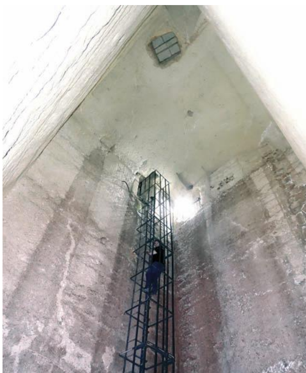
Fig. 5 - Interno della Neviera di masseria Radogna. Sulla volta è visibile la posizione della caditoia. Il alto sono visibili i due accessi. Al centro Francesco Foschino durante le operazioni di rilievo (foto R. Paolicelli)
