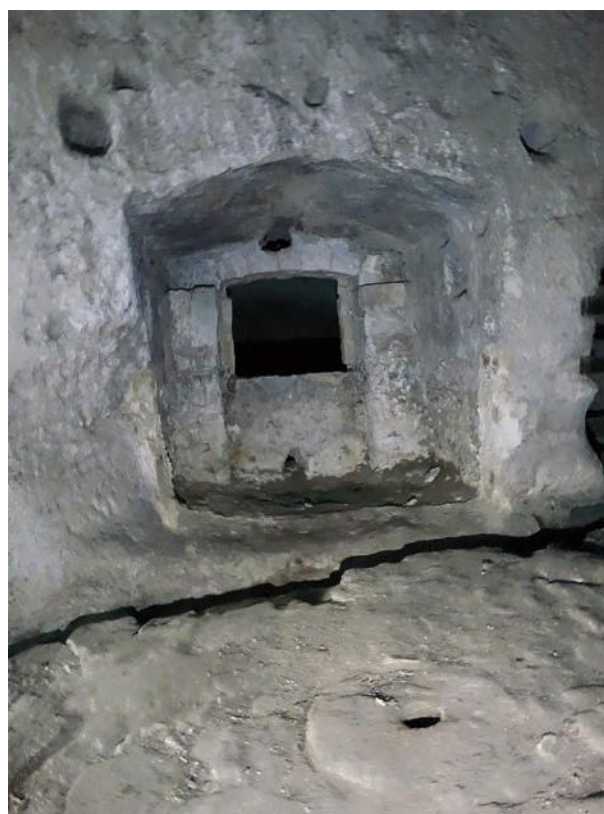
Fig. 6 - Porta di accesso di una delle due neviere (Vigoriti - De Parra) di via Casalnuovo. Nella parte alta si possono notare i fori di ancoraggio di travi facenti parte di una carrucola (foto R. Paolicelli)
