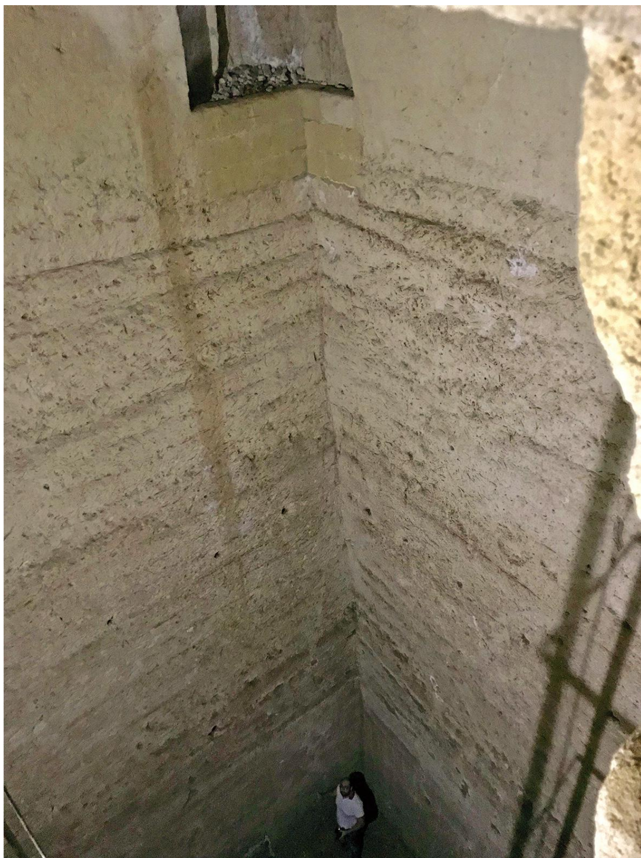
Fig. 4 - Interno della Neviera di masseria Radogna. Sul fondo, a 13 metri dalla volta, si nota Raffaele Paolicelli durante le operazioni di rilievo (foto F. Foschino)
