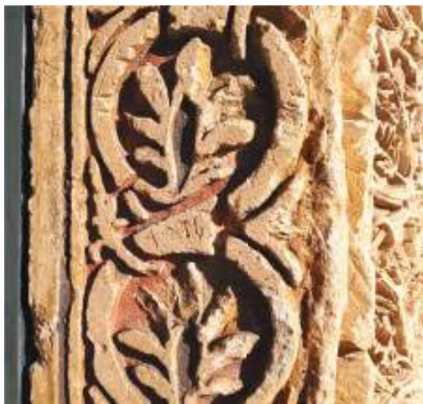
Fig. 22 – Particolare del pedritto destro del portale leccese: si noti l'effetto policromatico e polimaterico del decoro a tralcio, che ha il mastice rosso come fondo e quello nero nel pistillo a fuseruola e nei listelli laterali. Laddove il mastice è caduto si nota la profondità degli alveoli (variabile da 1,8 a 2,4 cm) e il rincasso perfettamente ortogonale al fondo (Foto S. Centonze)
