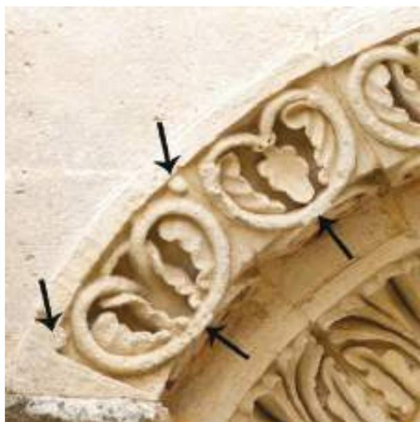
Fig. 6 - Particolare del fronte dell'archivolto absidale: monconi e fascette dovuti originariamente alla presenza dei listelli di chiusura degli alveoli dei conci e a quello di separazione tra le due facce dell'arco (Foto R. Giove)
