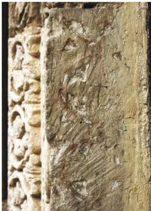
Fig. 23 - Portale sud di Santa Maria la Nova, Matera. Dettaglio del primo concio del piedritto sinistro, che nonostante la "piallatura" dell'intradosso e gli strati di malta cementizia, ci riconsegna l'impronta rossa del mastice, grazie alla quale è possibile ricostruire lo schema di intreccio del decoro a rose quadripetale (Foto S. Centonze);
