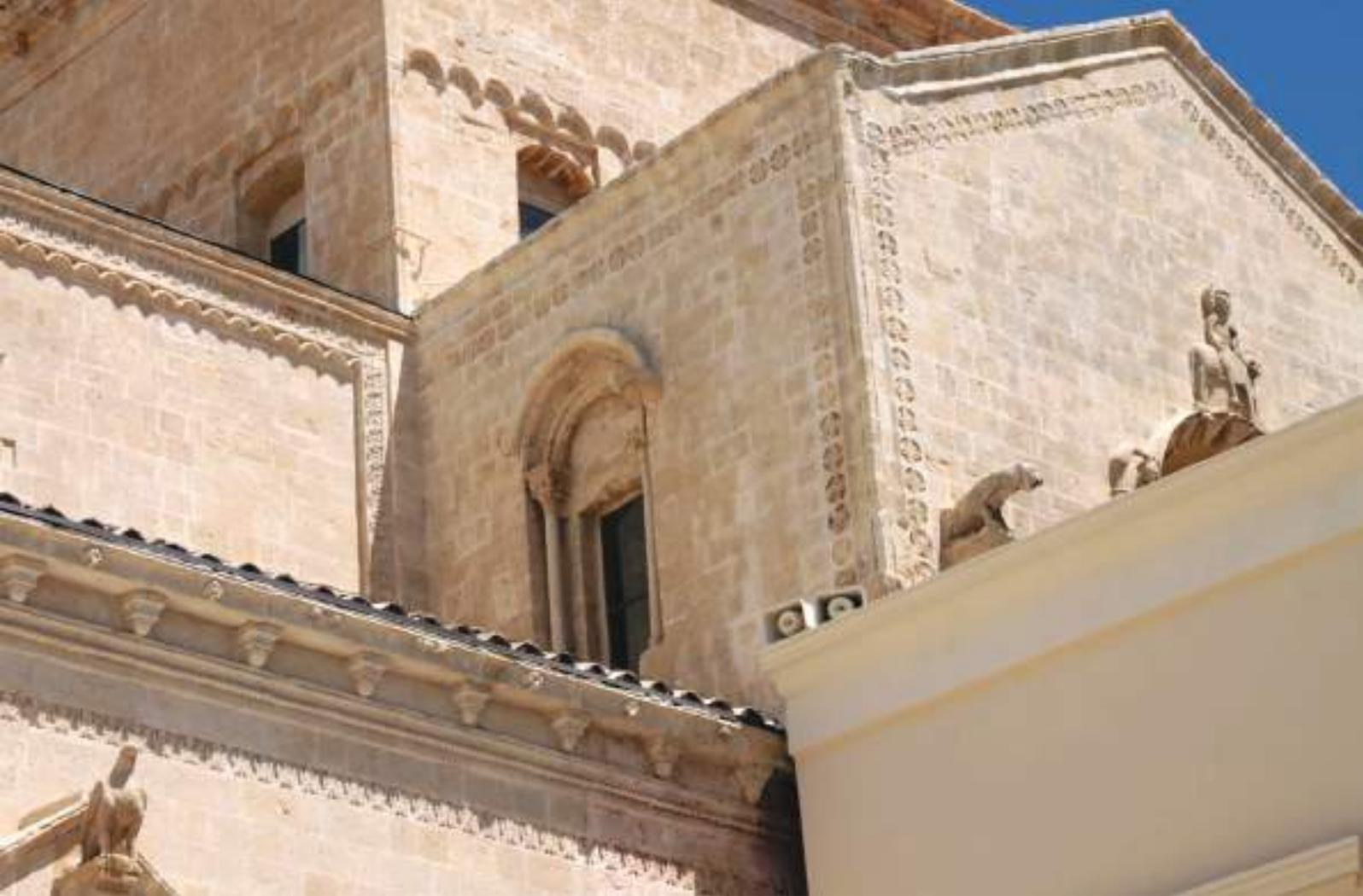
Fig. 26 - Cattedrale di Matera, incrocio tra le navate e il transetto, con il dettaglio dei fregi sommitali: motivo a gigli lungo le navate e la facciata ovest, decoro a rose quadripetale lungo il transetto. È evidente anche in basso a destra il residuo cromatico di una coloritura a pigmento rosso (Foto S. Centonze)
