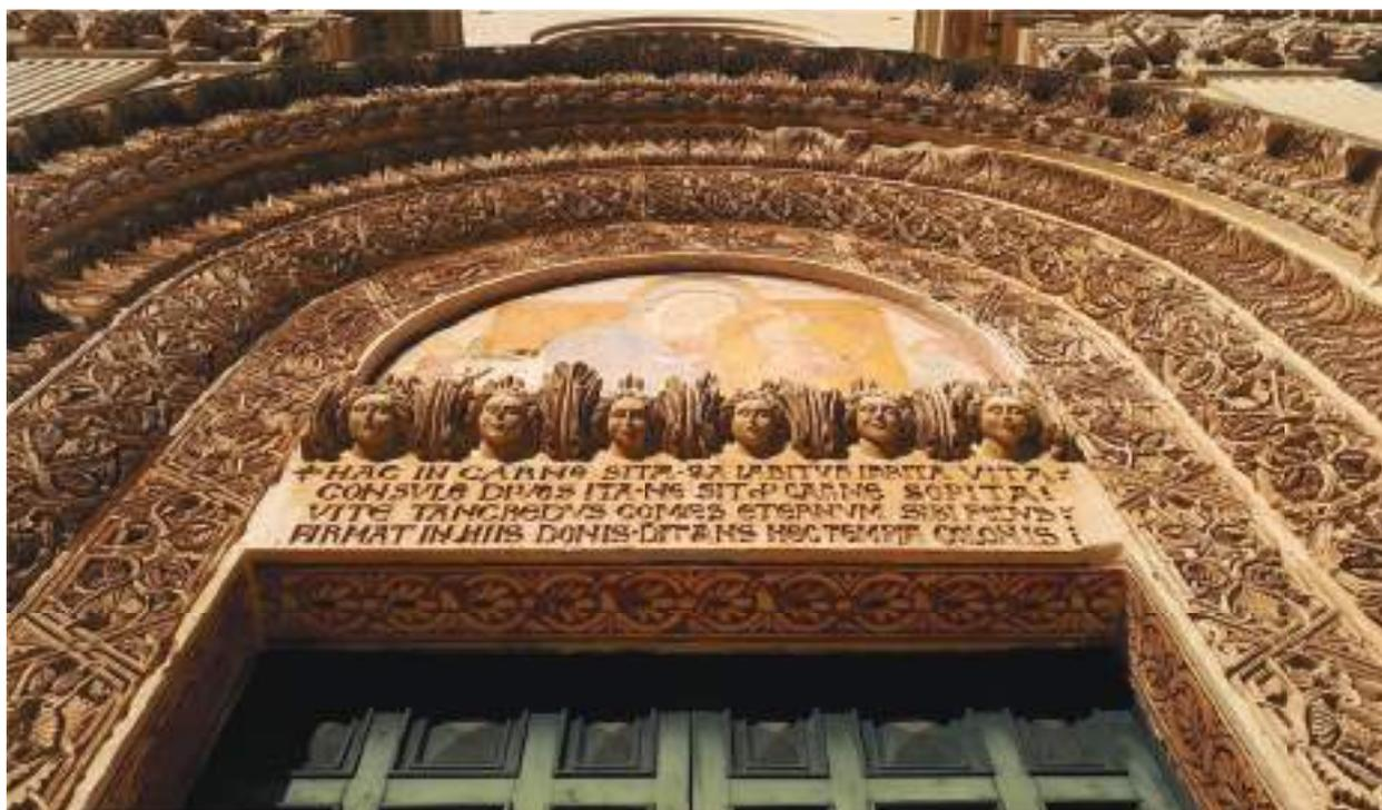
Fig. 21 – Particolare del portale principale della chiesa dei SS. Nicolò e Cataldo in Lecce: il decoro a girali, incrostato di mastice rosso e nero, segue l'intradosso in modo continuo, dai piedritti all'architrave, che sono ricavati da tre blocchi unici (Foto S. Centonze)
