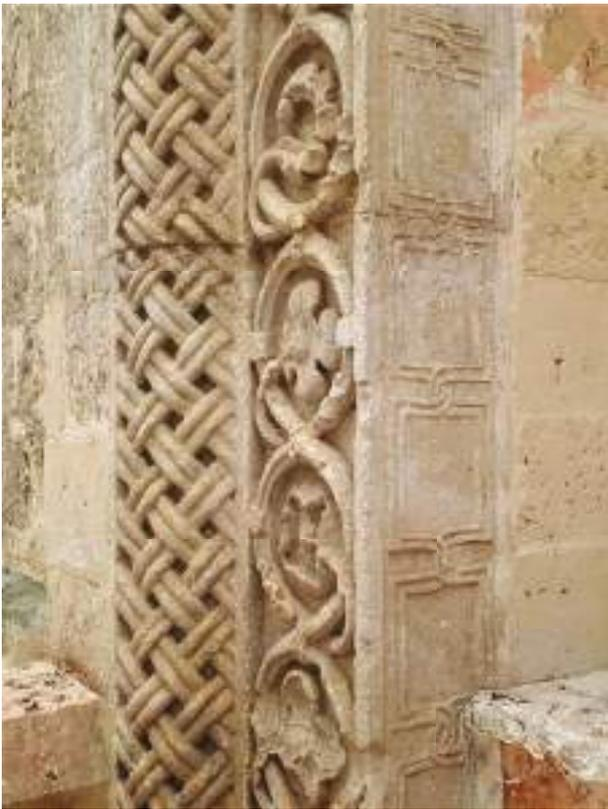
Fig. 15 – Dettaglio del portale ovest di Santa Maria la Nova, ritrovato negli anni Novanta: la ghiera esterna è un intreccio vimineo voluminoso, quella interna è una decorazione a girali che inquadra il retro della corolla di un fiore all'attaccatura del gambo. L'intradosso è scolpito in pochi millimetri di spessore, con un intreccio nastriforme che crea dei campi quadrati ampi e vuoti (Foto S. Centonze)
