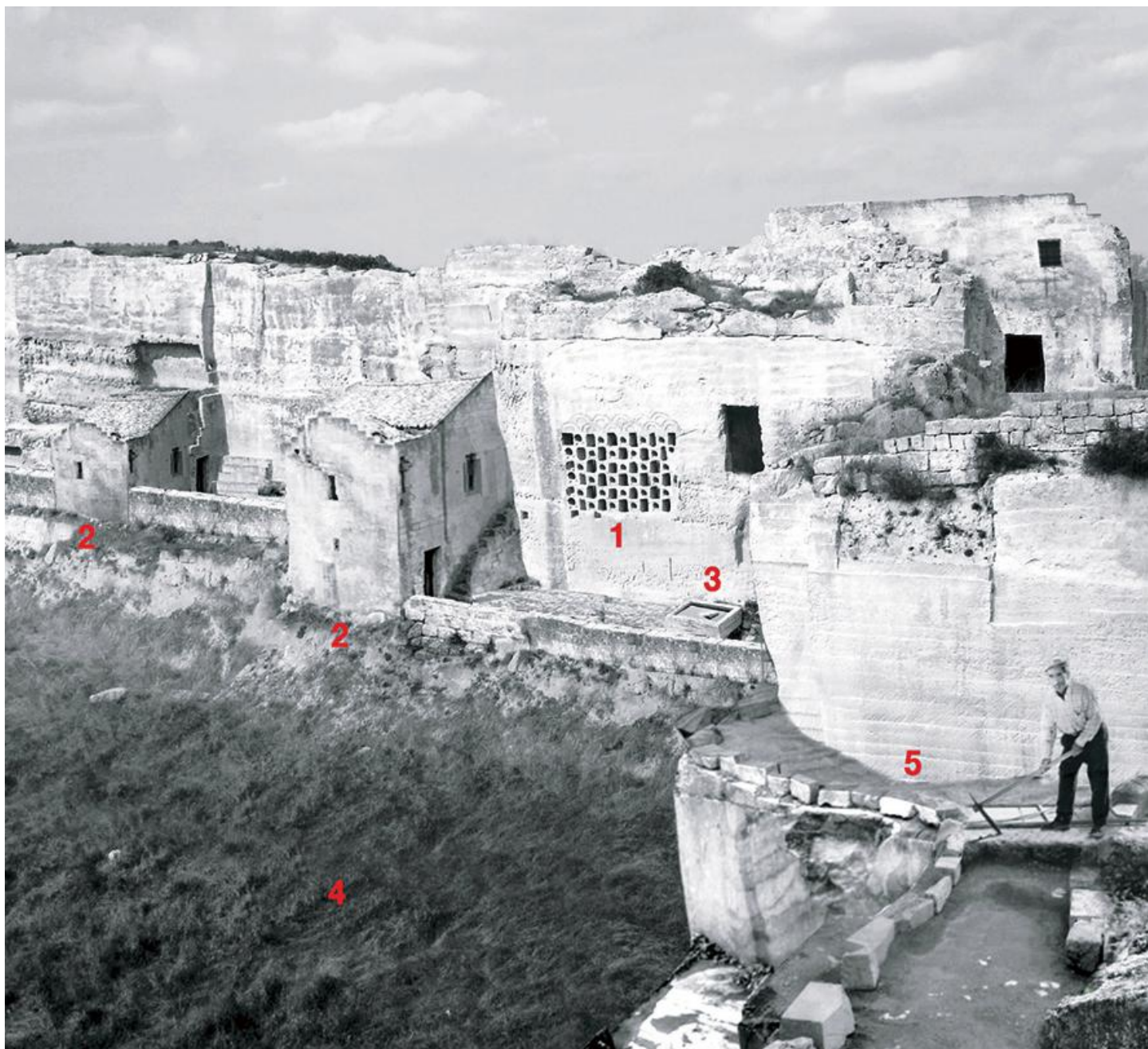
Fig. 16 - Legenda: 1 Avucchiara; 2 Melario + alloggi; 3 Acqua; 4 Giardino per impollinazione; 5 Cavamonti; 6 Percorso San Gregorio (elaborazione a cura di D. Gallo e M. Acito)
