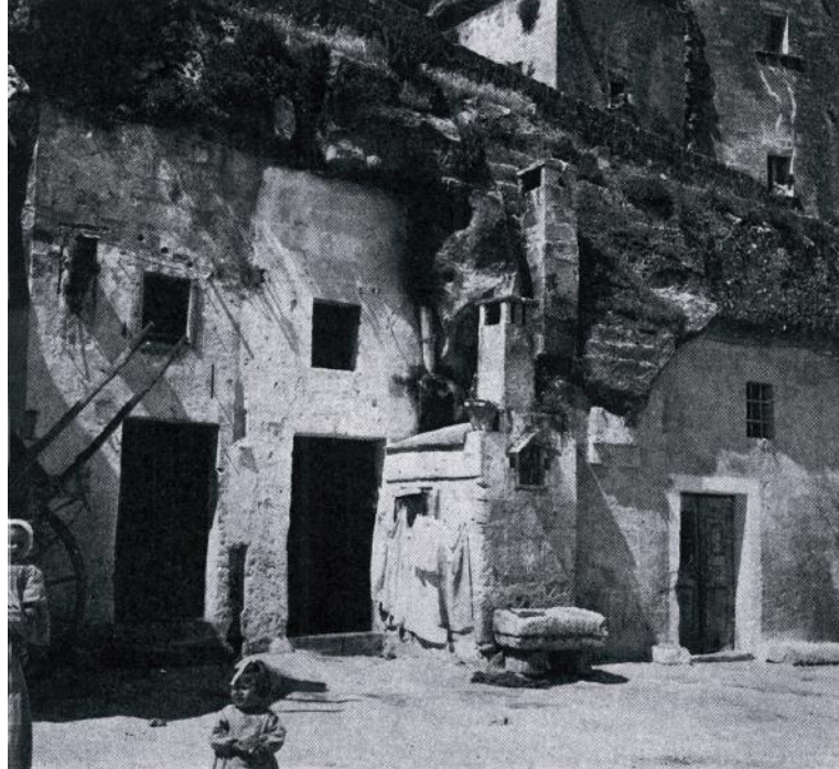
Fig. 5 - Tre case grotta con le porte di ingresso e le finestre poste in alto. Al centro i comignoli di due delle grotte, e sopra di loro il parapetto della strada sovrastante. Davanti le case una pila ricavata in roccia per lavare i panni
