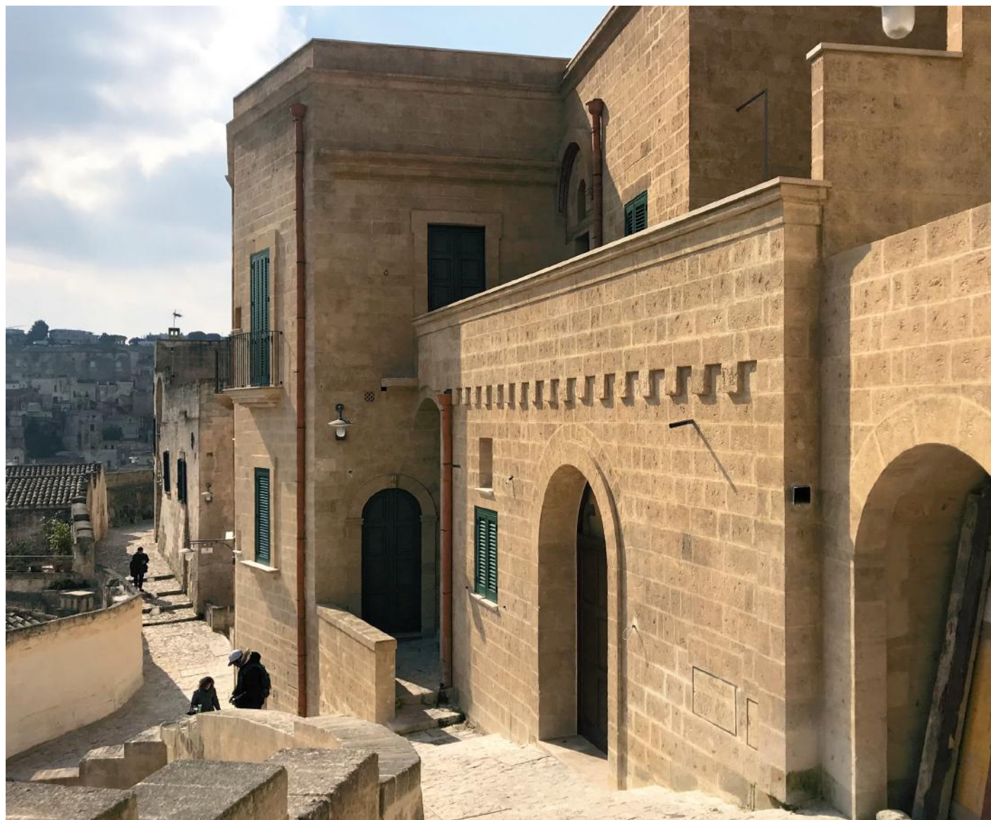
Fig. 4 - Ingresso del palazzo Zicari su via S. Giacomo (foto F. Foschino)
