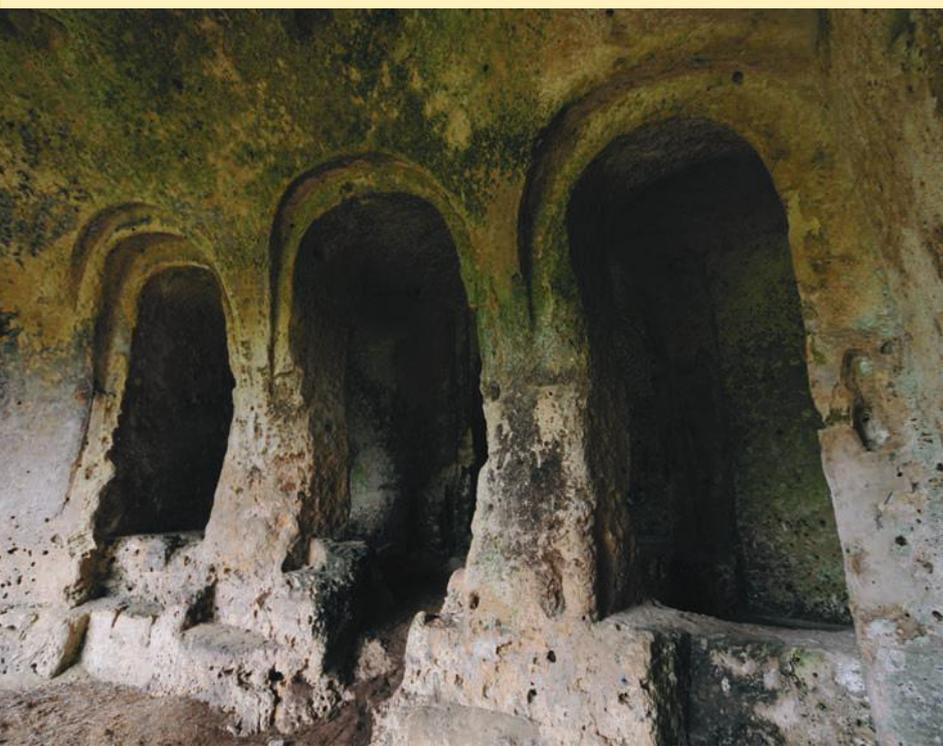
Fig. 4 - Mottola, chiesa presso masseria Scarano. La divisione del presbiterio ricavato in ambiente scavato in epoca classica. Da notare la continuità tra pareti laterali e volta e tra triforio e la stessa volta
