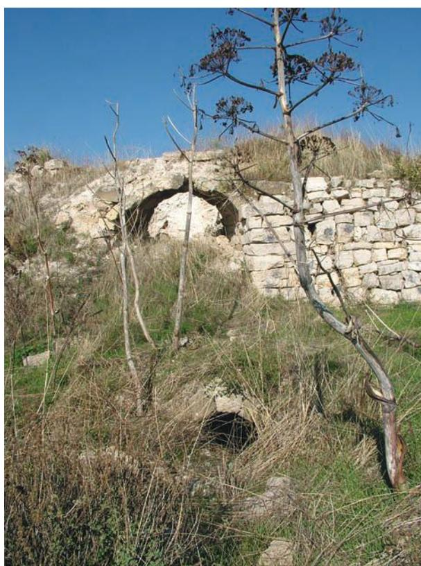
Fig. 7 - *Calcara* con cunicolo per l'apporto del combustibile e arco di accesso per il collocamento delle pietre da calcinare
