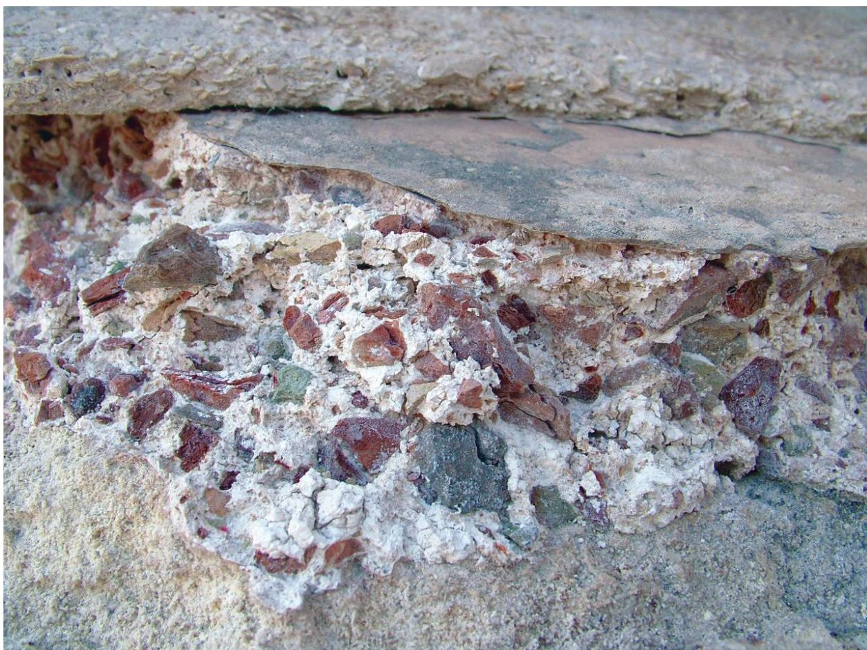
Fig. 17c - Contrada San Lazzaro: sezione di intonaco a cocchio pesto in una cisterna
