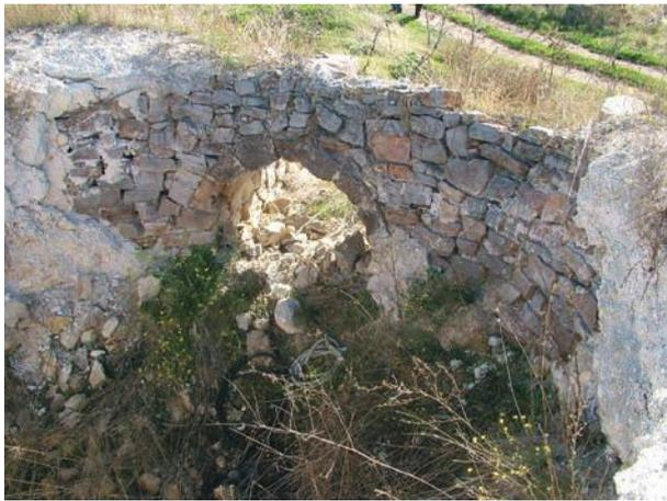
Fig. 8 - Interno di una *calcara*: si osservino, a sinistra e a destra, i resti della calce
