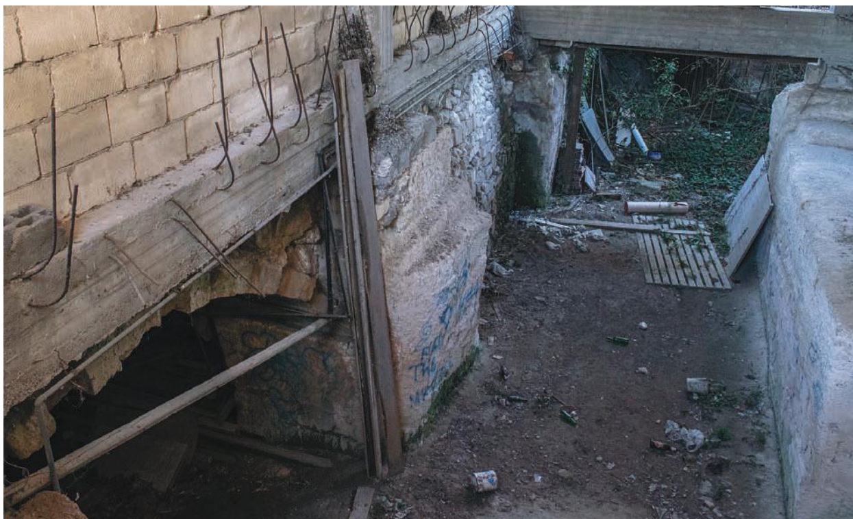
Fig. 15 - Lo sbancamento per una nuova costruzione, con cantiere in attuale stato di abbandono all'angolo fra Via Nazionale e Vico III Nazionale, ha reso visibili antiche preesistenze, quali una volta a botte e tracce di locali ipogei (Foto E. Lamacchia, 2020)
