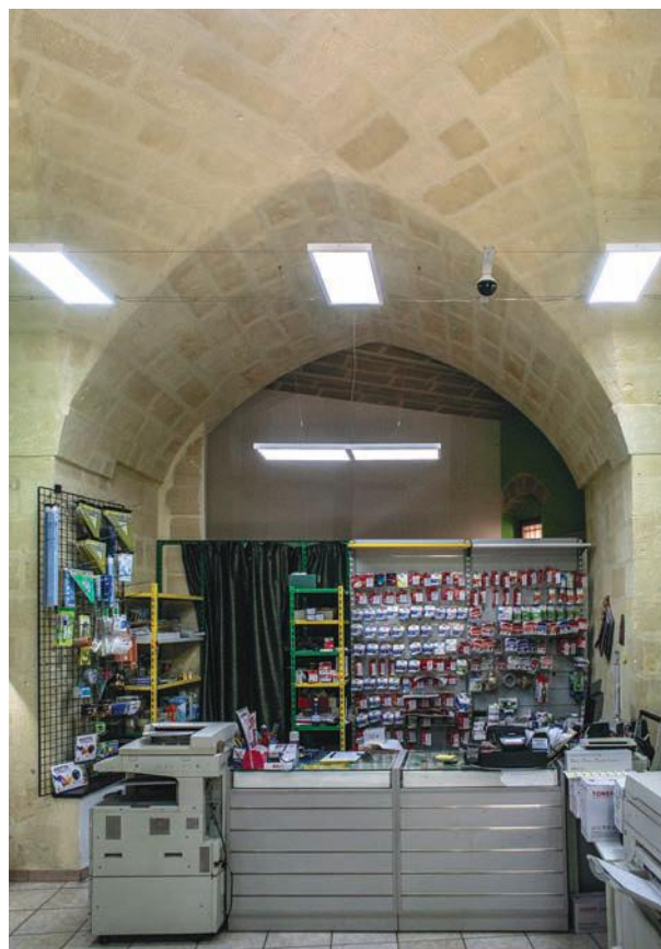
Fig. 14 - Le volte in muratura originali superstiti di Casino Giuralongo all'interno di odierne attività commerciali ai civici 150 e 154.
