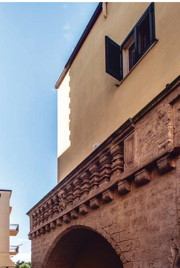
Fig. 5 - Casino Vizziello, dettaglio balaustra, unico elemento visibile superstite dell'originario edificio, foto E. Lamacchia 2020
