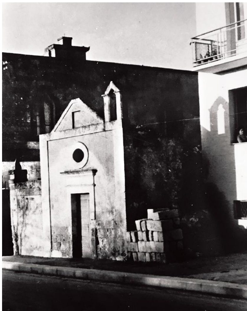
Fig. 6 - Cappella della Madonna del Rosario, anni Sessanta. Demolita negli anni Settanta, era ubicata all'altezza dell'attuale civico 136. Su concessione dell'Archivio Fotografico della Soprintendenza Archeologica Belle Arti e Paesaggio della Basilicata
