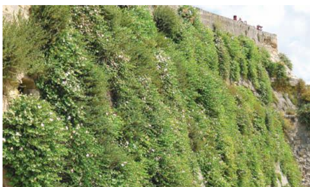
Fig. 2 - Cappereto in via Muro a Matera
