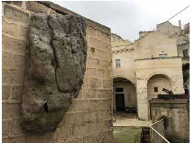
Fig. 9 - Ponte San Pietro Caveoso: finta roccia, totale e dettaglio
