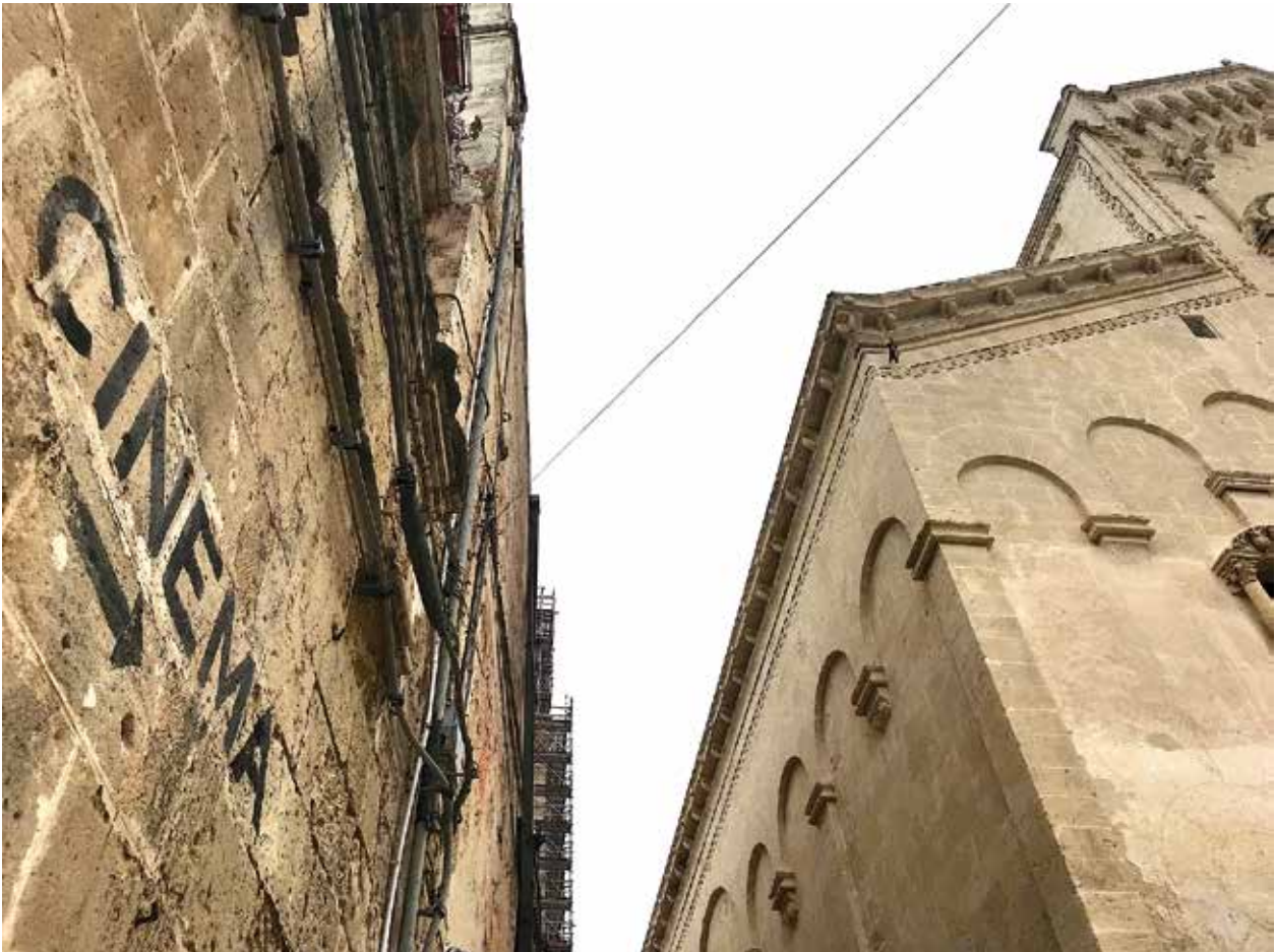
Fig. 11 - L'indicazione CINEMA direziona verso Via Riscatto
