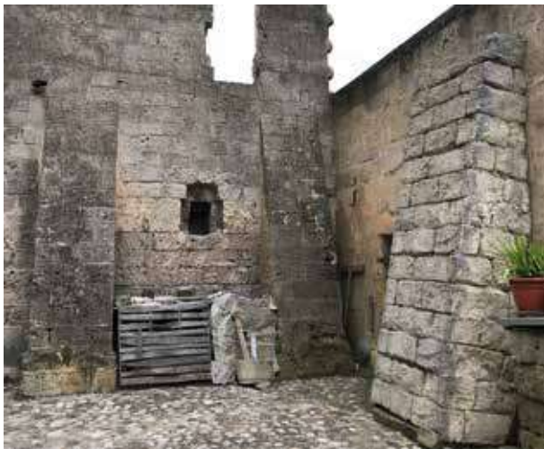
Fig. 7 - Finto contrafforte, Recinto Ospedale Vecchio
