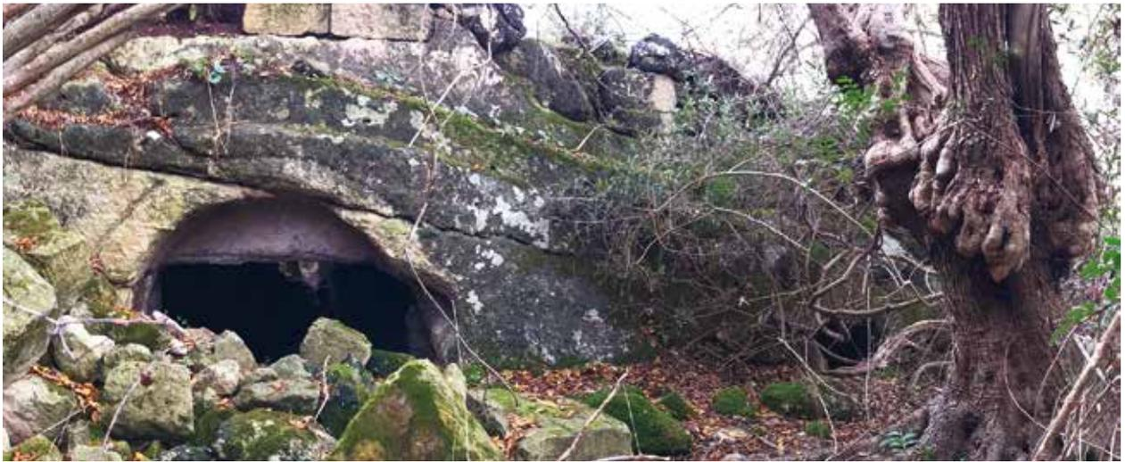
Fig. 8 - Il raffinato accesso originario al frantoio, quasi totalmente interrato e quindi murato. La sommità dell'ingresso appare libera per un crollo dei conci alti del muro di tamponamento, in primo piano. Sul piano di calpestio alluvionale un ulivo secolare. (foto Francesco Foschino)
