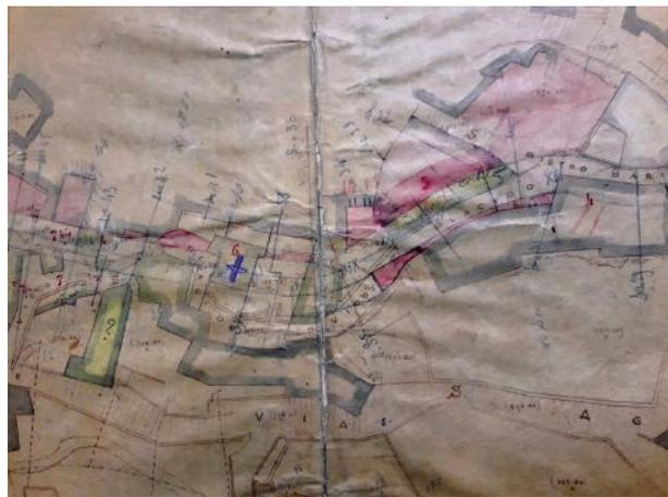
Fig. 4 - Progetto di costruzione della strada via D'Addozio e di demolizione di alcuni stabili tra i quali compare la chiesa cappella di San Placido, segnata da una croce blu [Archivio di Stato di Matera, Genio Civile, 1° Vers., b.668, fs.6866]
