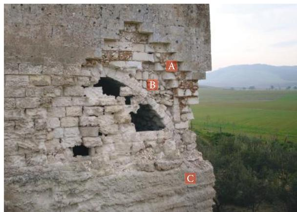
Fig. 3 - A) Riempimento dell'intercapedine tra due pelli di tufo con pietrame di risulta legato da argilla; B) Riempimento a secco del rinfiacco di una volta a botte con pietrame di risulta da cava di tufo; C) Cava - Matera, Masseria del Cristo (foto Raffaele Paolicelli)
