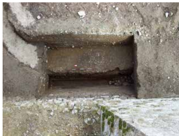
Fig. 3 - Differenza di quota per il piano di fondazione di cinta e contrafforte
