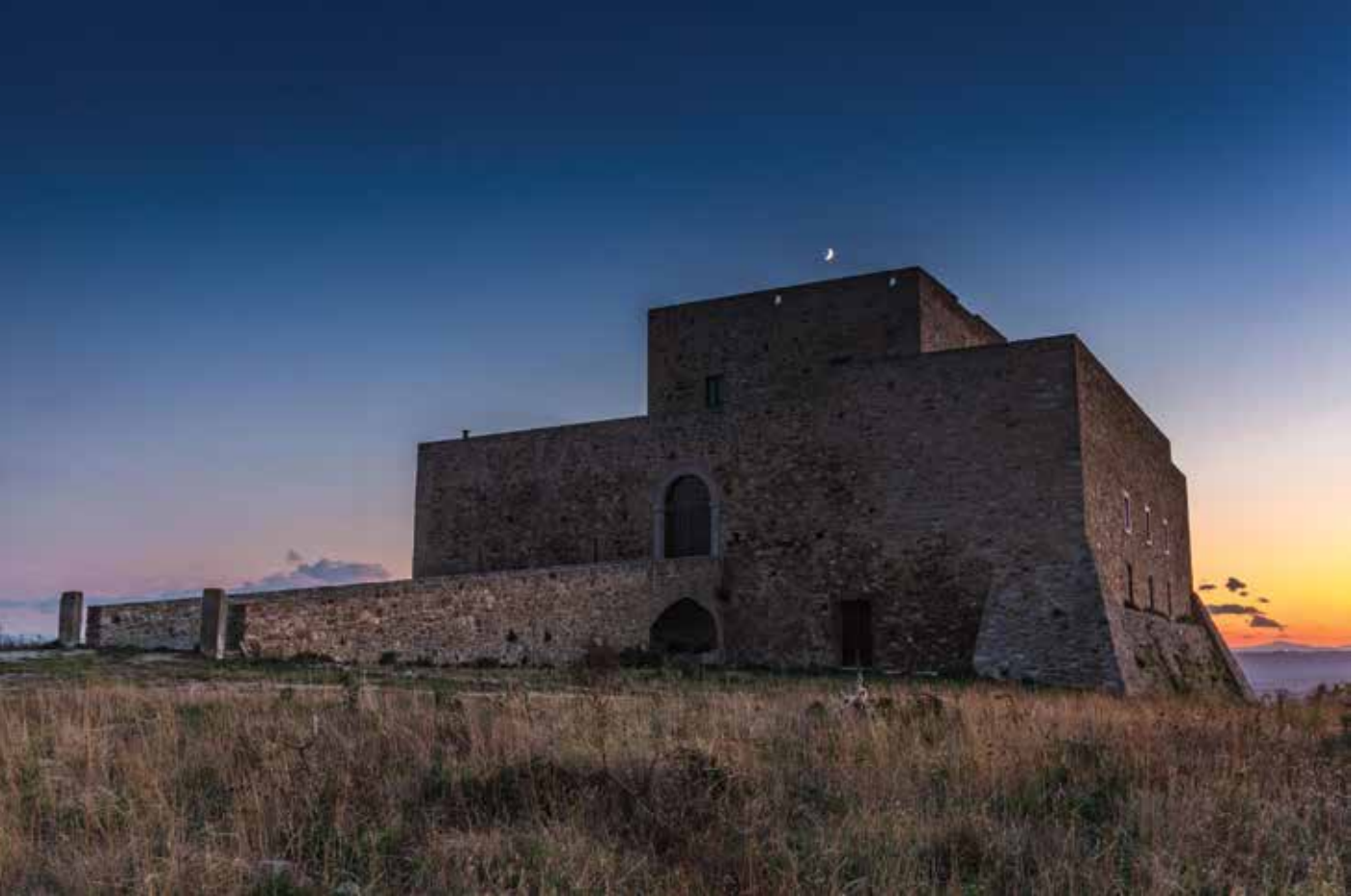
Fig. 8 - La rampa del castello dopo i restauri (foto R. Giove)
